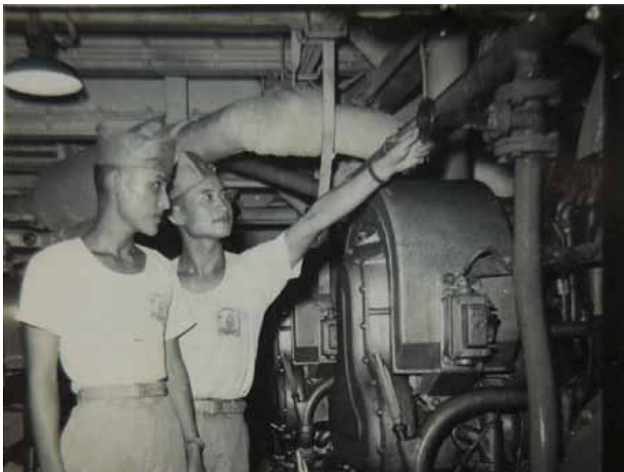
↑在機房檢查設施。
