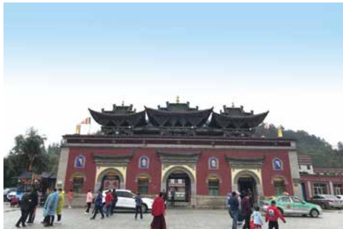
↑塔爾寺的牌坊。
